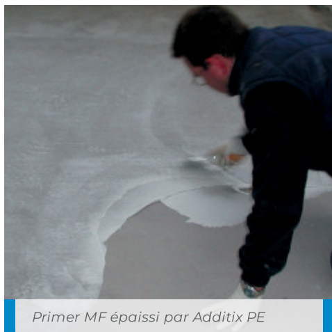
Injection d'un joint avec le Primer MF mélangé à l'Additix PE
