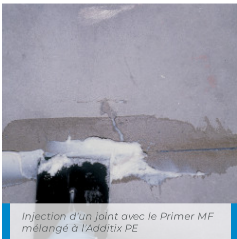
Mélange d'Additix PE dans Primer MF
