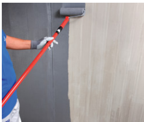
Application d'Eco Prim Grip Plus au rouleau sur du béton
