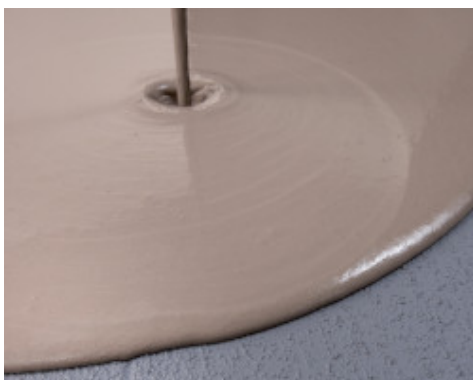
Application d'un ragréage autolissant sur Eco Prim Grip Plus sec sur un sol ancien
