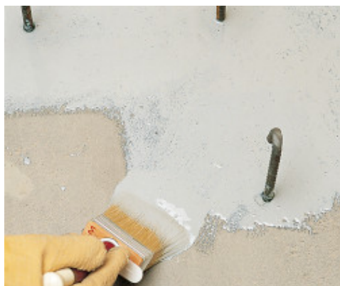
Application d'Eporip au pinceau sur des reprises de bétonnage
