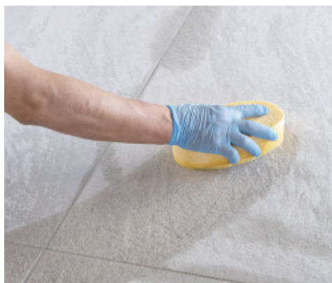
Nettoyage et finition des joints avec une éponge en cellulose dure
