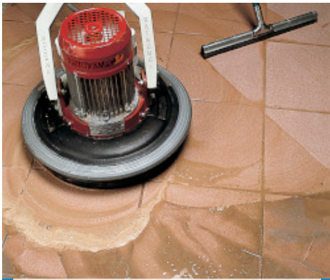
Finition des joints de grès cérame à la raclette et à la monobrosse
