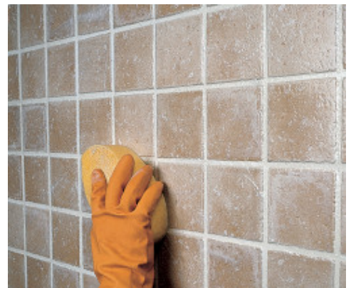
Finition d'un mur de grès étiré avec une éponge
