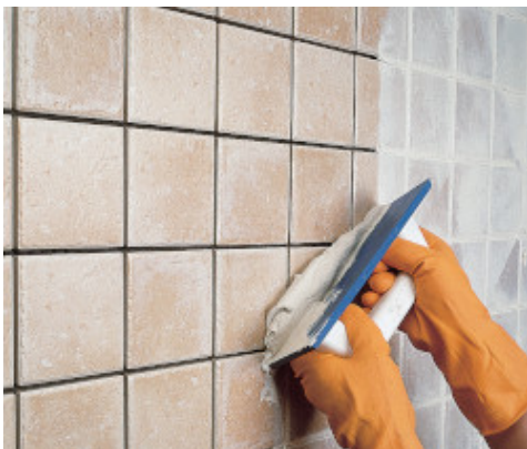
Jointoiement d'une paroi de grès étiré avec une spatule en caoutchouc
