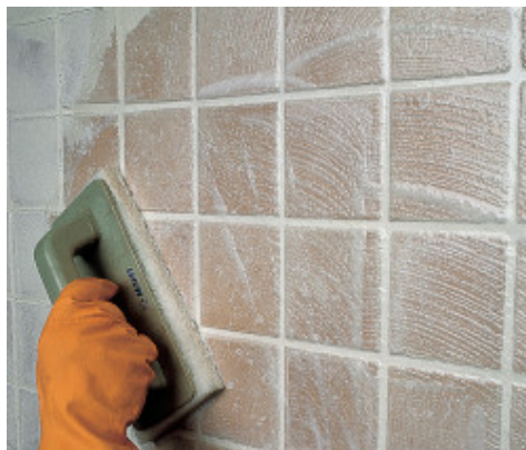
Finition d'une paroi de grès étiré avec un tampon Scotch-Brite®
