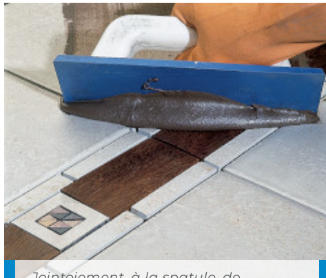
Jointoiement, à la spatule, de carrelage céramique avec insertion de bois
