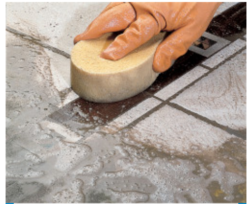
Finition à l'éponge, de carrelage céramique avec insertion de bois
