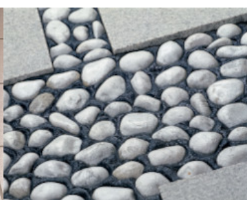
Exemple de jointoiment de pierres décoratives
