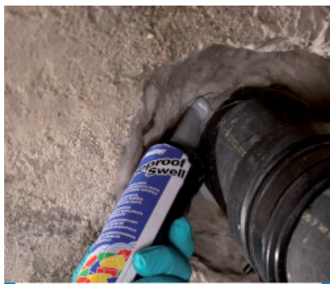
Rebouchage d'un élément à travers en utilisant Mapeproof Swell
