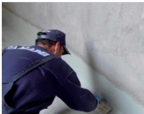
Mapelastic Foundation appliqué à la spatule pour imperméabiliser le sol de l'eau en contre-pression
