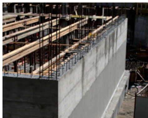
Mur de fondation rendu imperméable après moulage en utilisant Mapelastic Foundation
