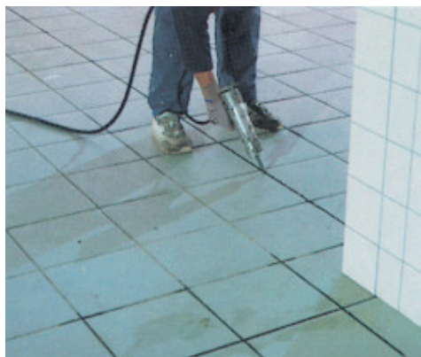
Jointoiment d'un sol carrelage avec Mapesil AC
