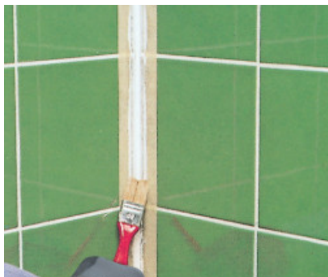
Lissage du joint avec de l'eau savonneuse et un petit pinceau
